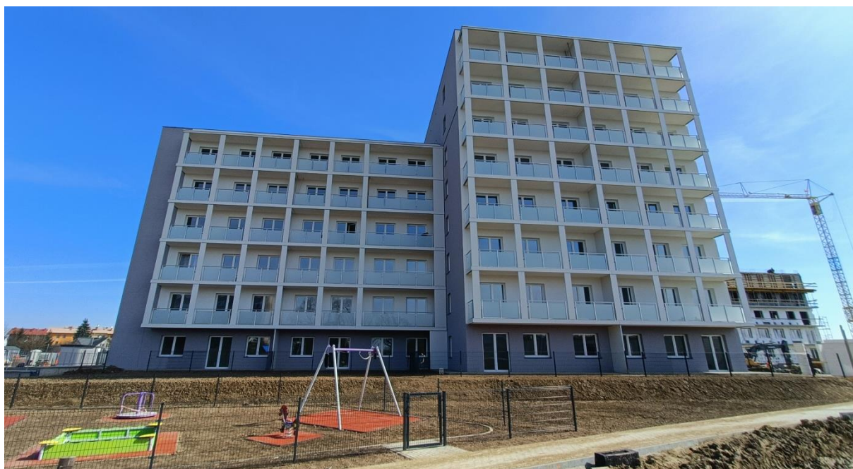
Fot. 5. Inwestycja Towarzystwa Budownictwa Społecznego przy ul. gen. J. Hallera. Fot. archiwum TBS
