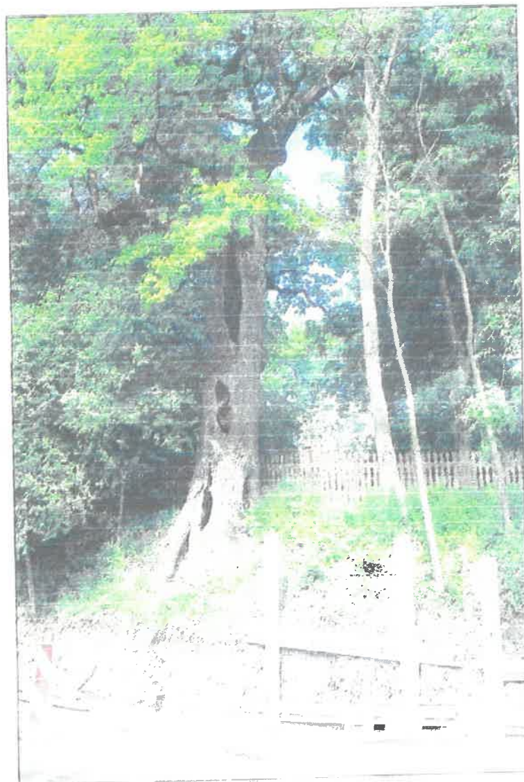
Fot. 3. Dąb, widok od strony południowej po wykonaniu wykopu dla ściany oporowej
