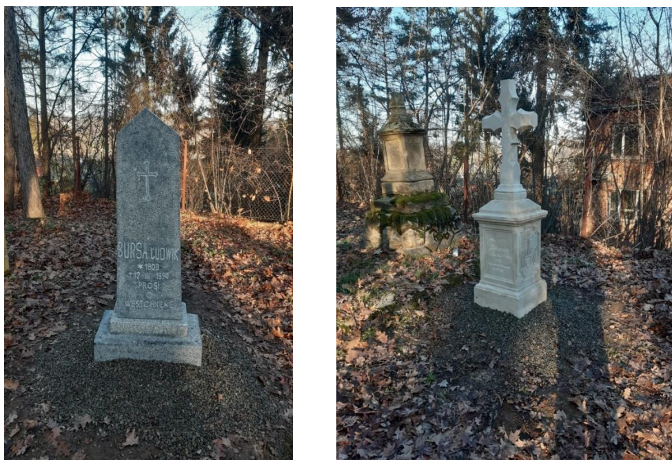
Fot. 2. Zdjęcia po przeprowadzeniu prac remontowo konserwatorskich
