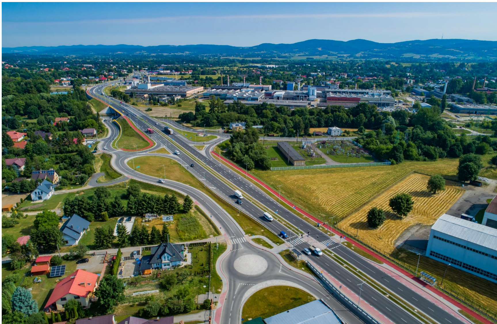
Fot. 10. Dobudowa drugiej jezdni obwodnicy miasta Krosna w ciągu drogi krajowej nr 28
