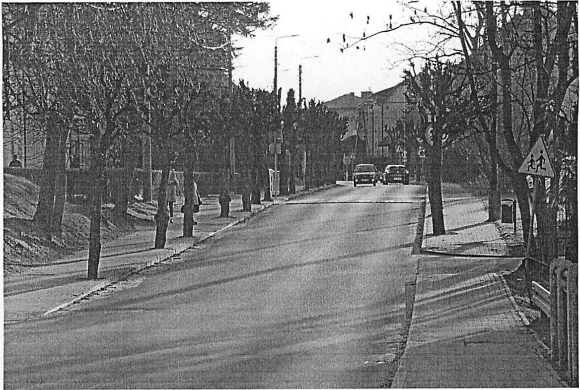
Fot. 3. Widok ogólny na ul. Paderewskiego. Widoczny bardzo dobry stan nawierzchni.
