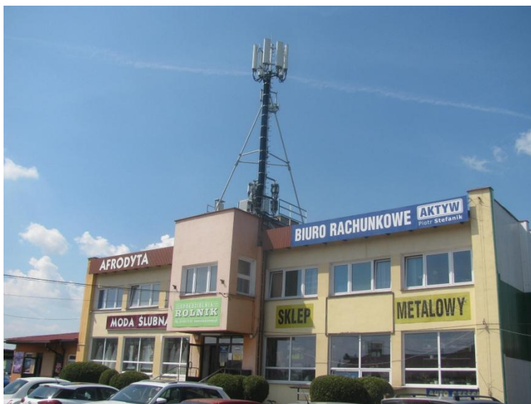
Zał. nr 1: Widok ogólny instalacji radiokomunikacyjnej.
