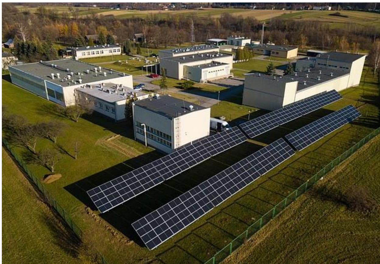
Fot. 11. Instalacja fotowoltaiczna w Zakładzie Uzdatniania Wody w Sieniawie. (fot. Krośnieński Holding Komunalny)
