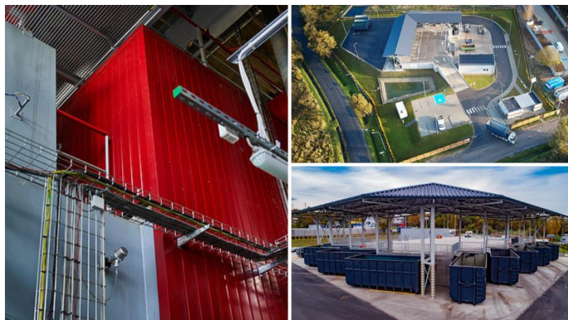
Fot. 10. Instalacja na biomasę w Zakładzie Energetyki Ciepłej oraz Punkt Selektywnej Zbiórki Odpadów (fot. Krośnieński Holding Komunalny)
