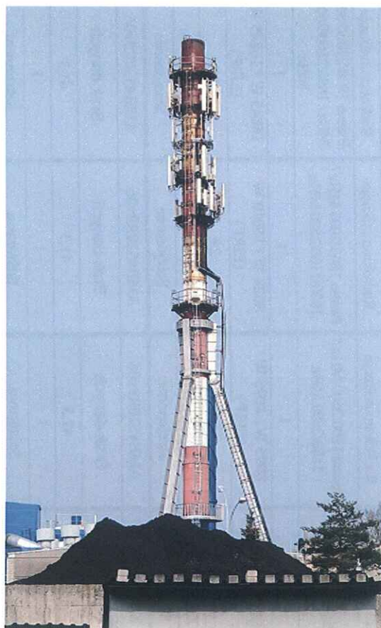
Fot. 1. BT_22248 Krosno South – widok obiektu
