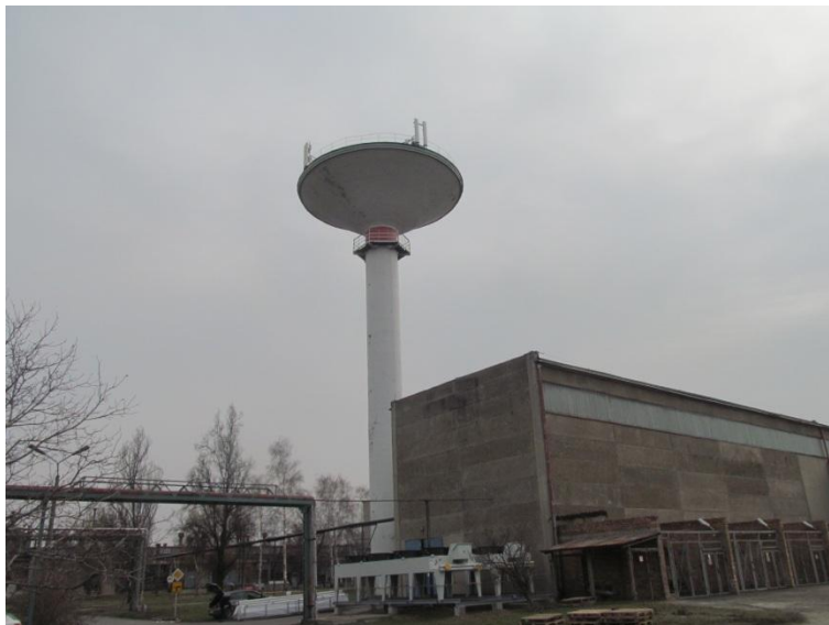
Zał. nr 1: Widok ogólny instalacji radiokomunikacyjnej.
