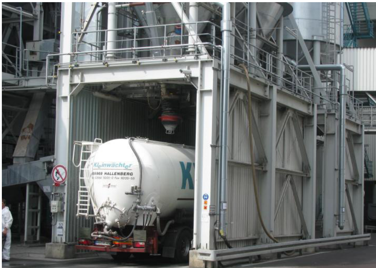
Rysunek 12: Silosy przejazdowe na pozostałości poprocesowe.
