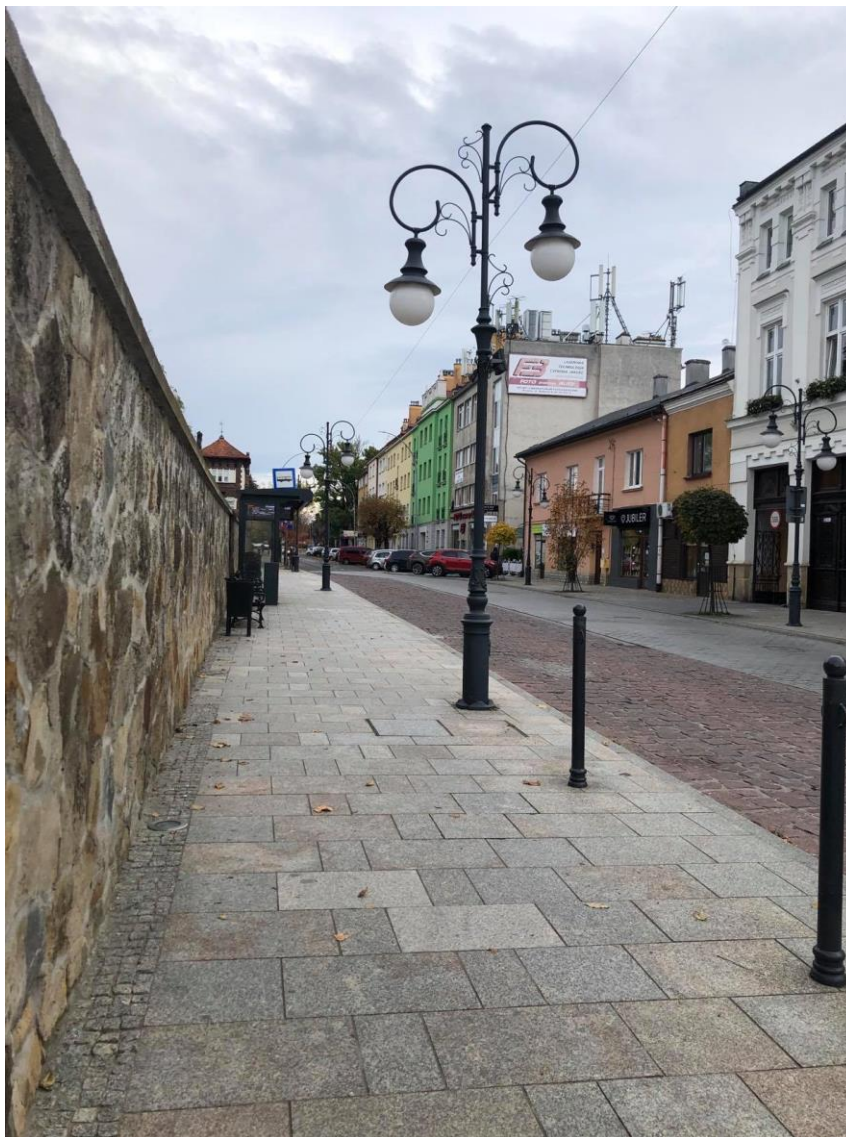
Zał. nr 1: Widok ogólny instalacji radiokomunikacyjnej.
