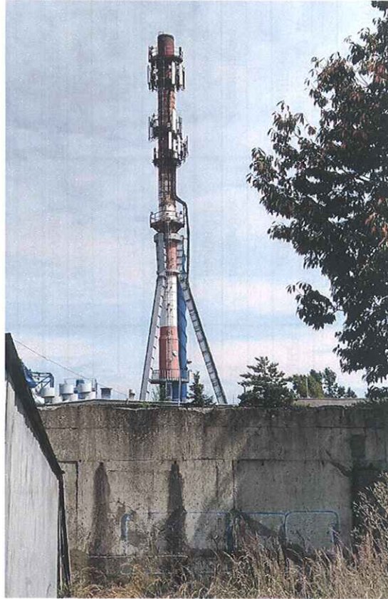
Fot. 1. BT_22248 Krosno South – widok komina z antenami
