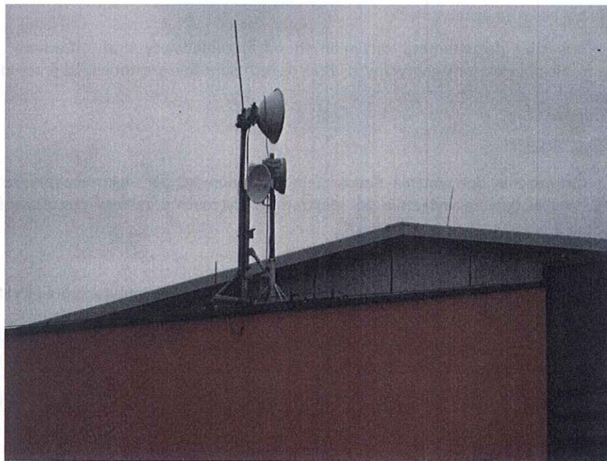
Zdjęcie 1 Badany obiekt
