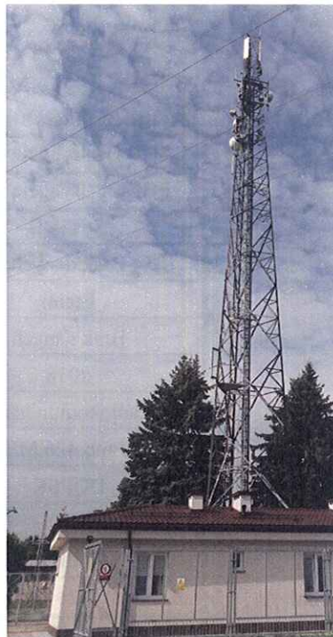
Fot. 1. BS Krosno – widok obiektu
