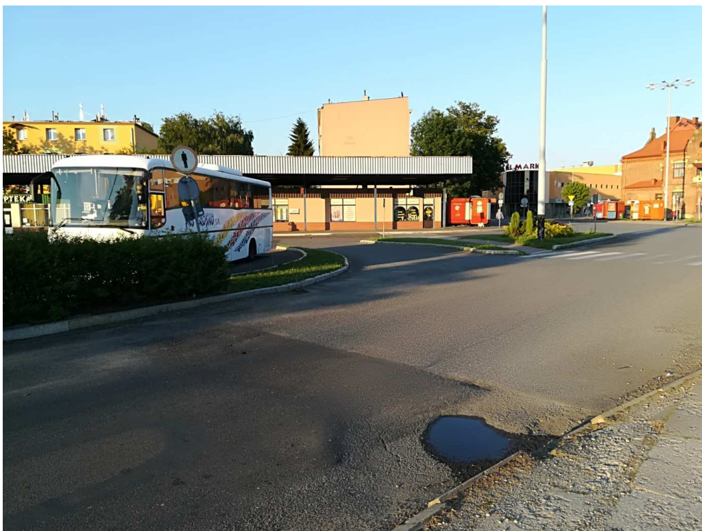
Fot. 5 Wyjazd z placu dworcowego PKS z kierunku miasta oraz jezdnia umożliwiająca podjazd na stanowisko autobusowe
