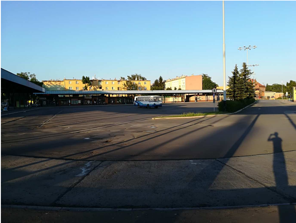
Fot. 2 Dworzec autobusowy PKS – widok od strony zachodniej
