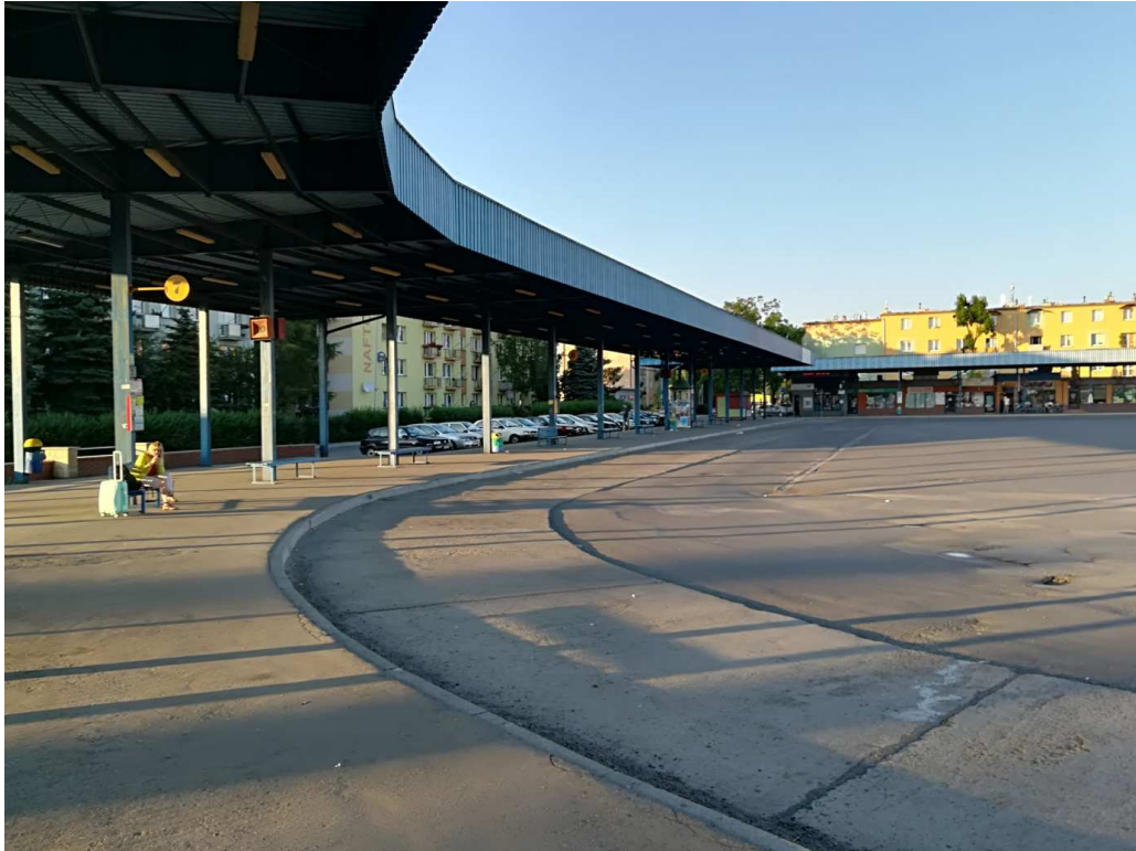
Fot. 3 Zadaszenie peronów dla pieszych przy stanowiskach autobusowych
