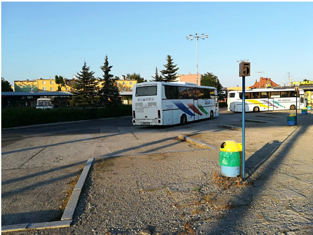
Fot. 4 Stanowiska autobusowe usytuowane ukośnie do jezdni
