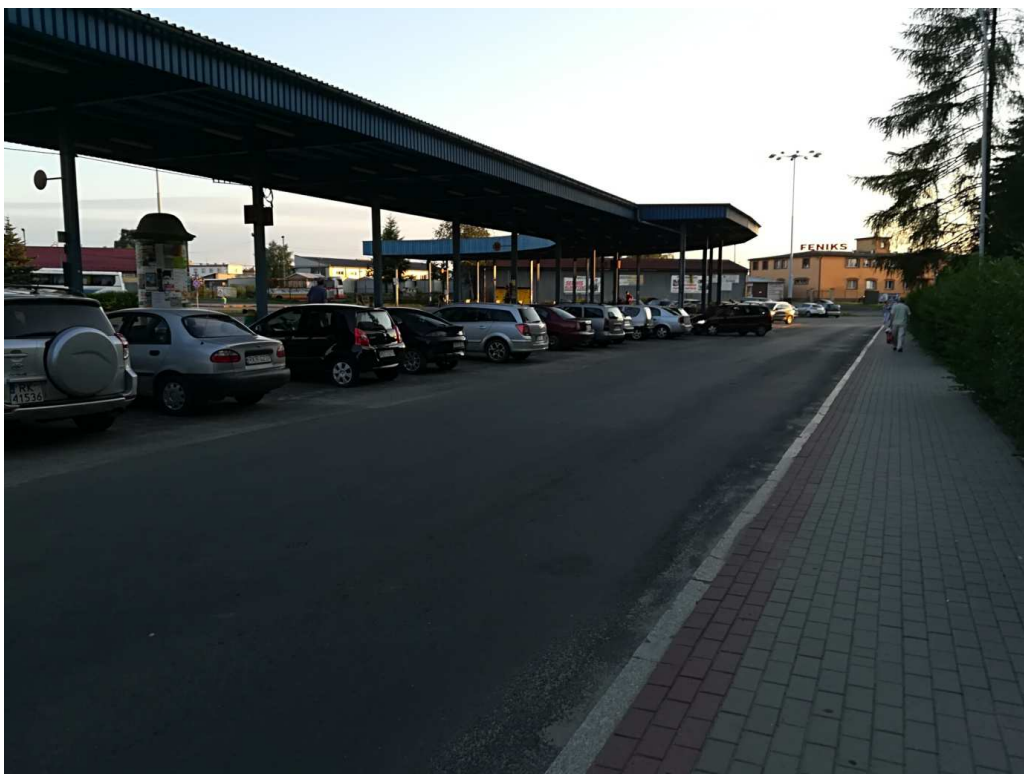
Fot. 13 Zatoka postojowa na zapleczu peronów dla pieszych od strony ul. Naftowej
