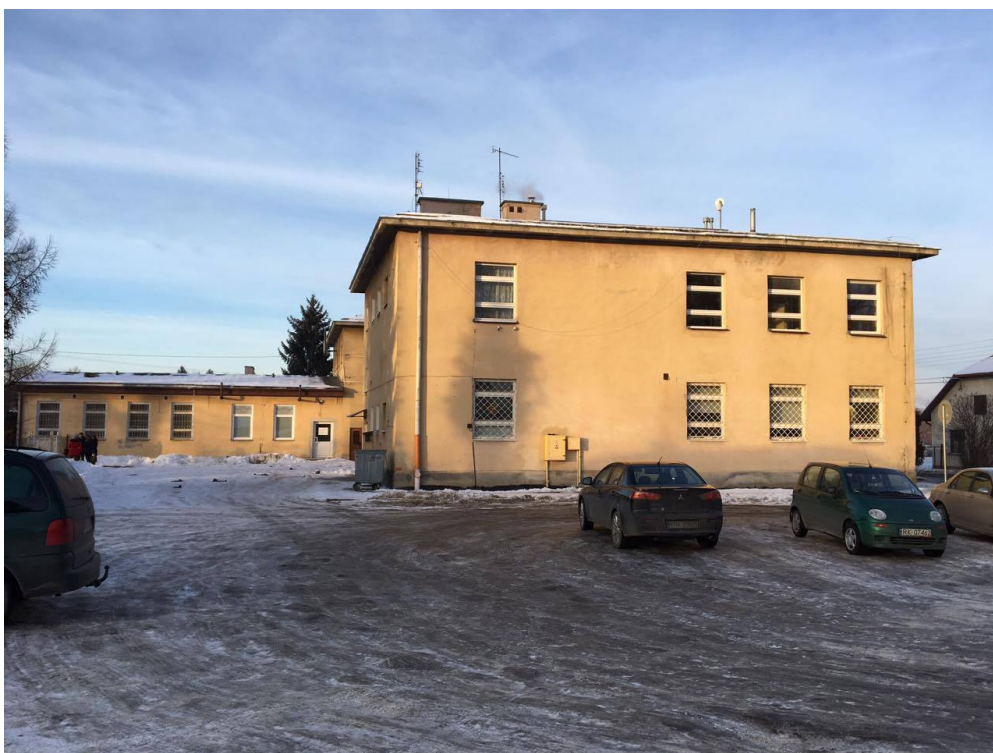
Fot. 4. Budynek przy ulicy Decowskiego 46.
