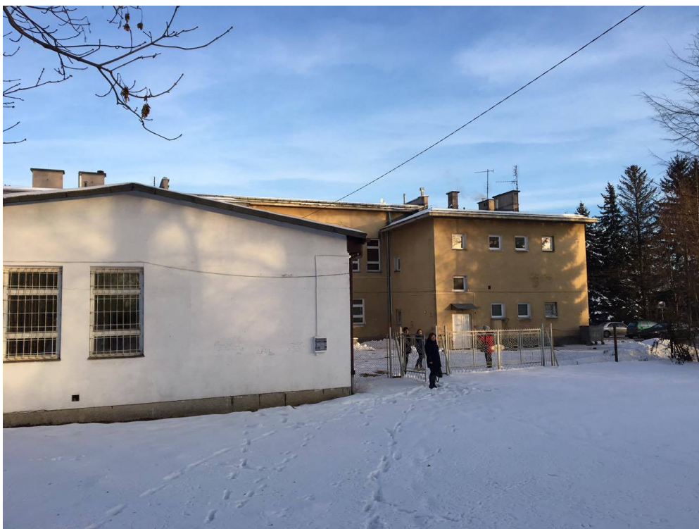
Fot. 3. Budynek przy ulicy Decowskiego 46.
