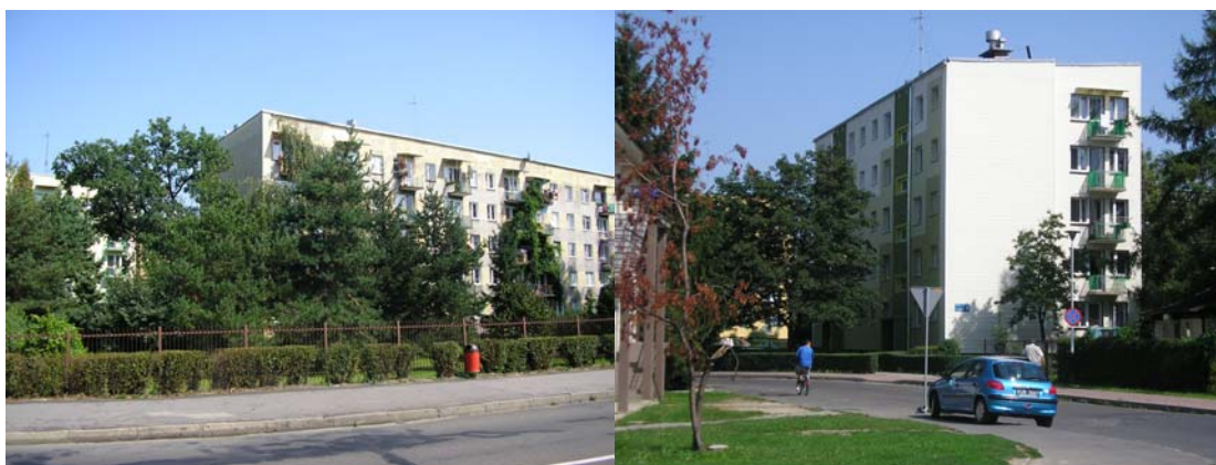
Rysunek 10. Widok budynków wielorodzinne przed i po termo modernizacji
