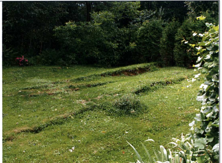
Szczeliny przy domu 51
