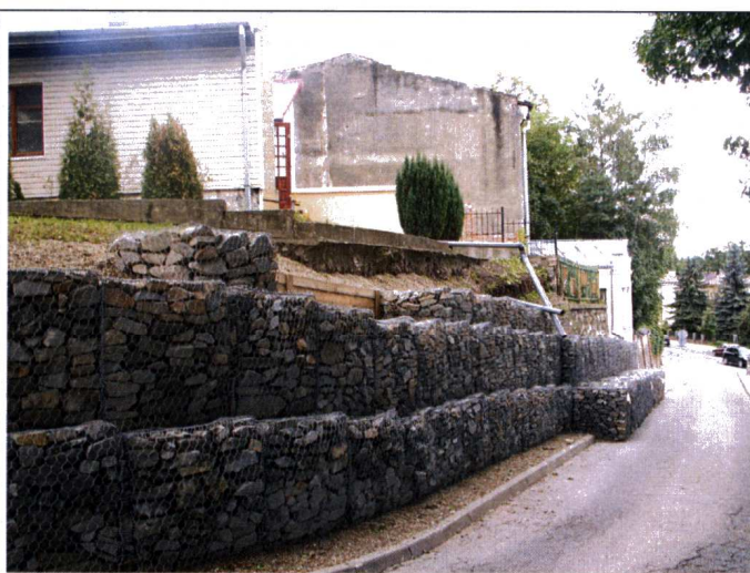
Wykonane zabezpieczenia na ul. Zjazdowej
